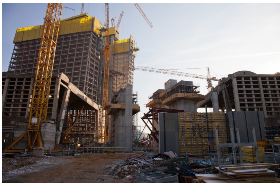
Figura 69 Obras de cimentación del edificio de entrada
