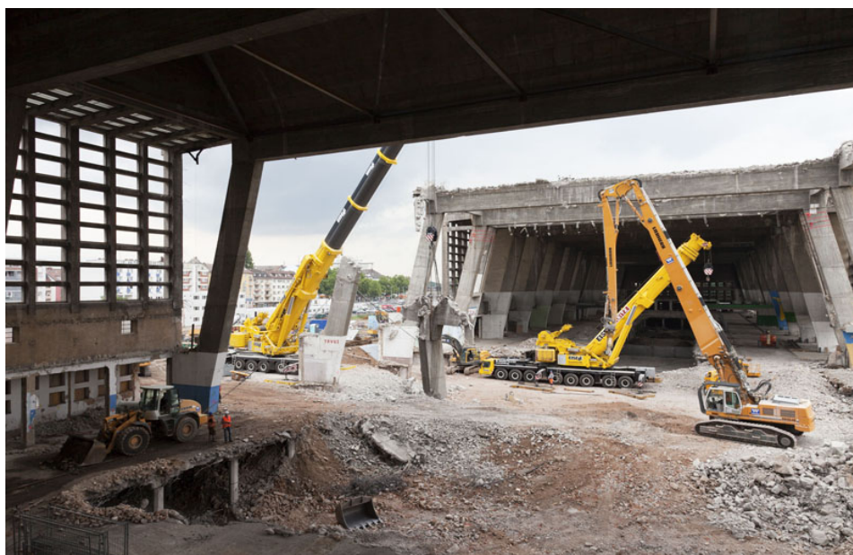
Figura 68 Obras de demolición, entrada
