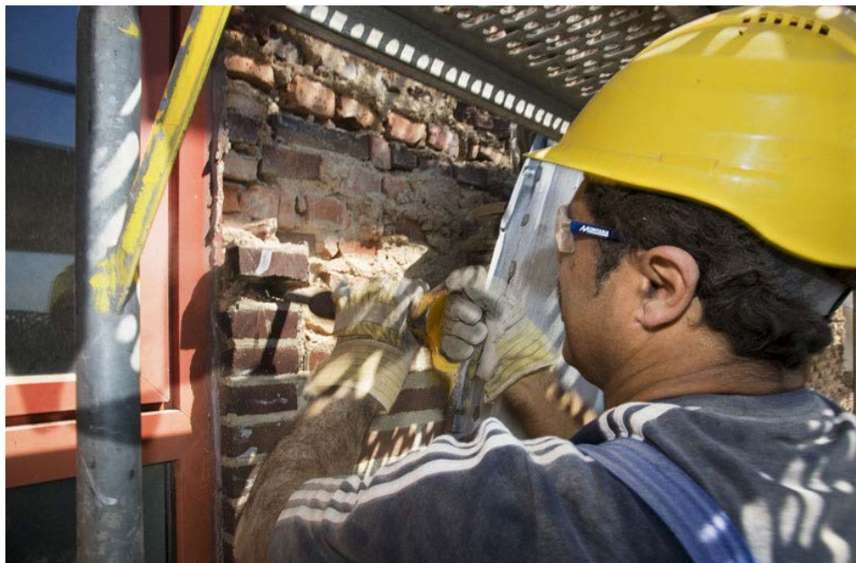
Figura 61 Retirada a mano de ladrillos y demolición del anexo oeste
